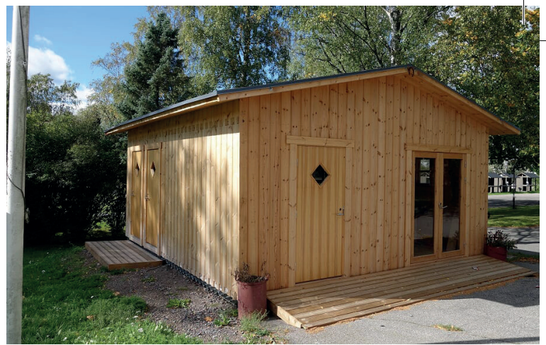
▲ Harvinaisen järeä pystyhirsinen pihavarasto Teijoconin toimiston takapihalla oli ensimmäisiä menetelmän sovelluksia.
